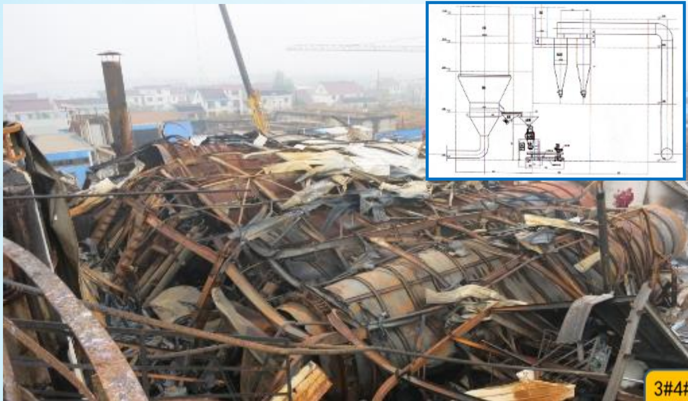
造粒包装车间整体倒塌
