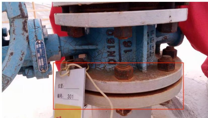
某企业罐组一储罐T-101和T-107油气回收管线进储罐末端法兰设置了盲板，经追溯，上述盲板均未办理堵盲板作业许可。
