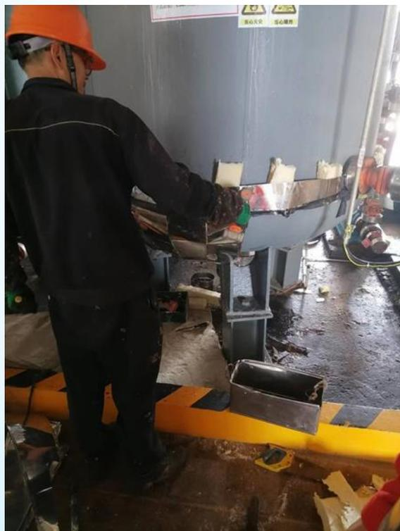
外委承包商作业人员在A区四车间D3装置一楼对氯苯计量罐进行保温作业，作业工具：电钻，未办理动火作业票。
