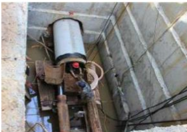
(e) 深基坑和地下管沟
